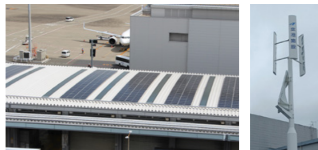
自家消費型の羽田空港国内貨物ターミナル太陽光発電設備(左)とハイブリッド・自立型電灯(右)
