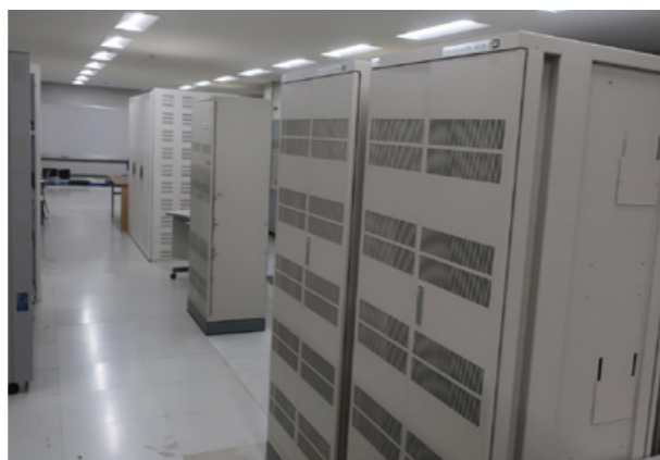
共用通信設備
