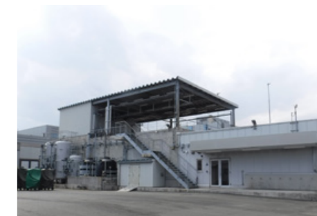
大型航空機洗機施設
