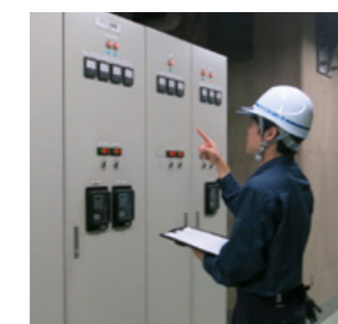
保守点検作業
