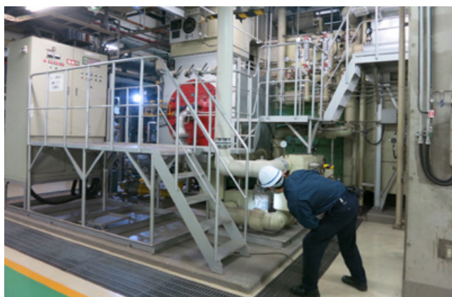
地域冷暖房設備
