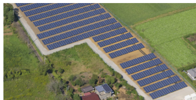
遊休地を活用した太陽光発電設備(本三里塚)
