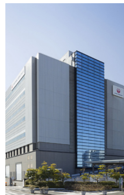
第1テクニカルセンター (羽田空港)
