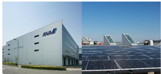
コンポーネントメンテナンスビル
