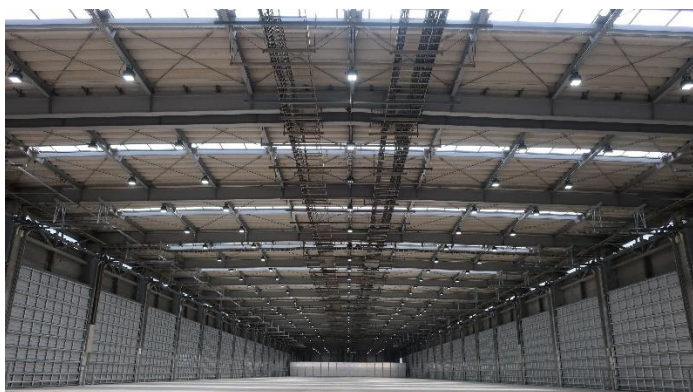
【羽田空港国内貨物ターミナル】
