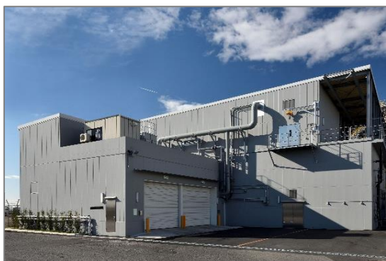
【SDプラント 外観】
