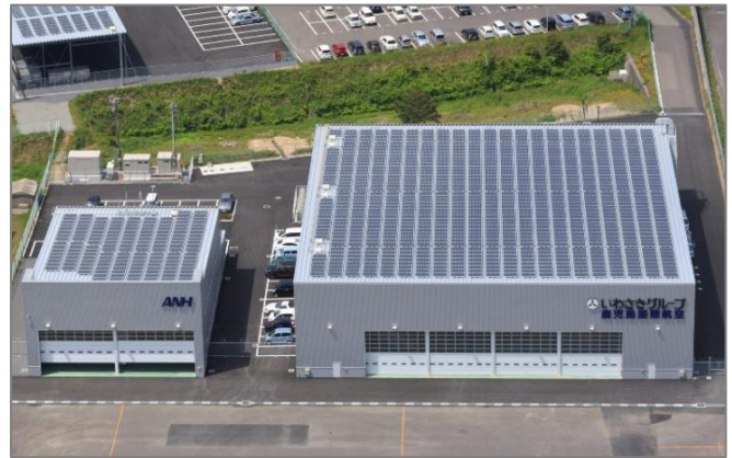
【鹿児島空港第一・第二格納庫（太陽光パネル設置）】
