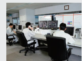
コントロールルーム (東京空港冷暖房株式会社) Control room (Tokyo Airport Heating & Cooling)
