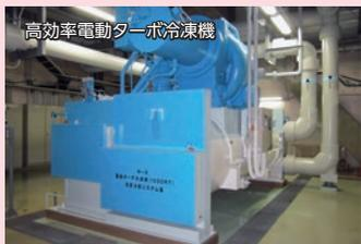
高効率電動ターボ冷凍機
