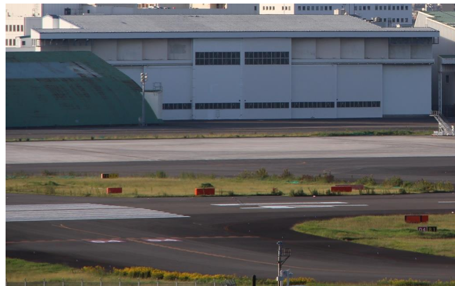
大型格納庫（東京国際空港 旧整備場地区B滑走路付近）
