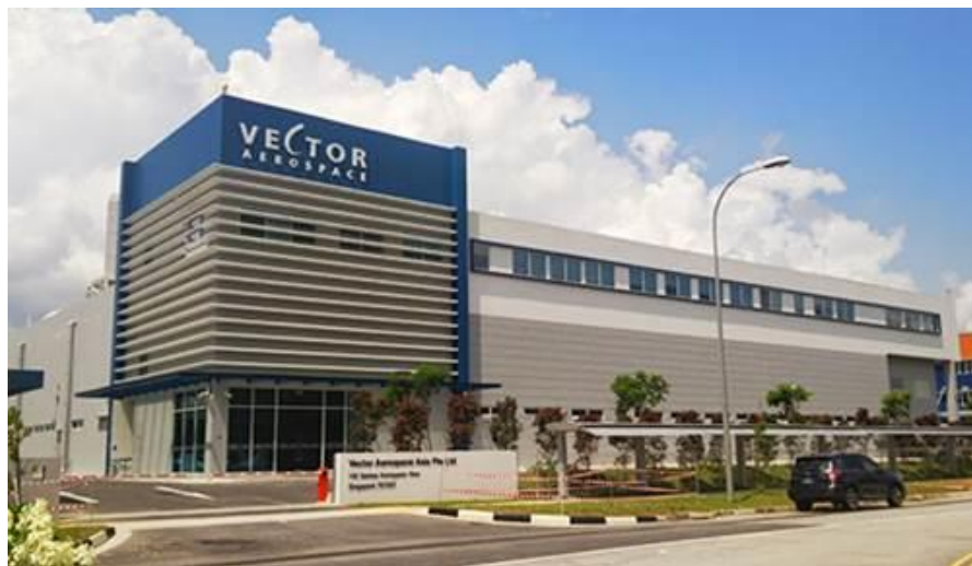
エンジン整備工場 (シンガポール・セレーター空港)
