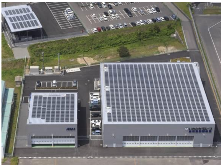
鹿児島格納庫 屋上太陽光パネル
