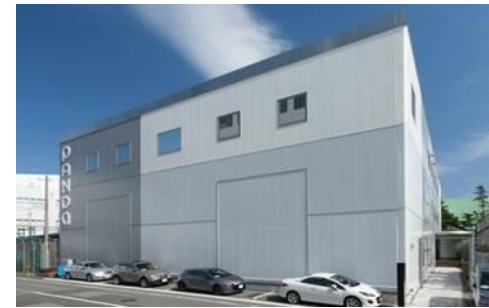
パイロット訓練施設 (東京国際空港 旧整備場地区)
