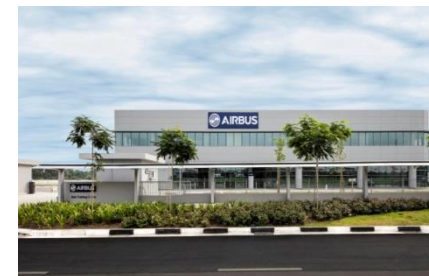
パイロット訓練施設（シンガポール・セレータ-空港）
