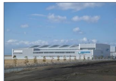
神戸空港格納庫 【神戸空港】
