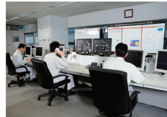
24時間体制のコントロールルーム
