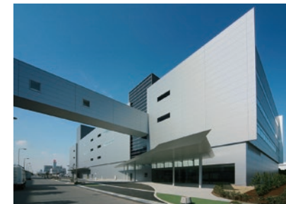
航空機の電子・電気関連部品等の整備工場
