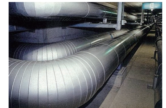
地域配管(共同溝内)
