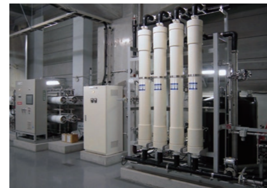
節水対応の冷却水リサイクル装置
