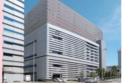
エネルギーセンター(東京空港冷暖房株式会社)
