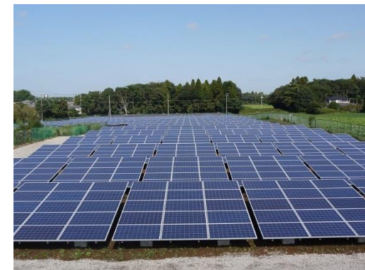
太陽光発電施設
