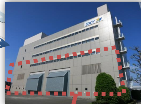
メンテナンスセンターアネックス増築工事
