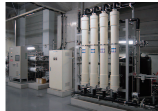
節水対応の冷却水リサイクル装置
