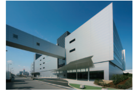
航空機の電子・電気関連部品等の整備工場
