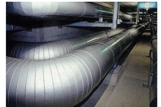
地域配管(共同溝内)
