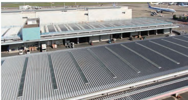
太陽光パネル
