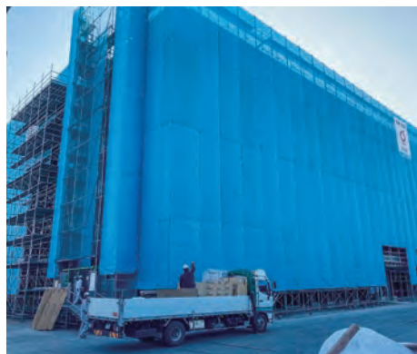
施工中外観(2020年11月現在)
