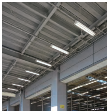
LED照明設備
