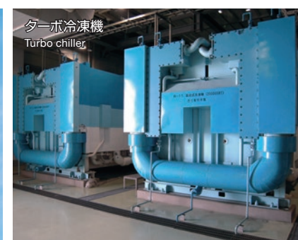
エネルギーセンター (東京空港冷暖房株式会社) Energy Center (Tokyo Airport Heating & Cooling Co., Ltd.)
