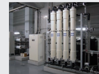
冷却水ブロー水リサイクル装置 Coolant water and blow-off water recycling device
