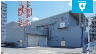
東京国際空港SDプラント
