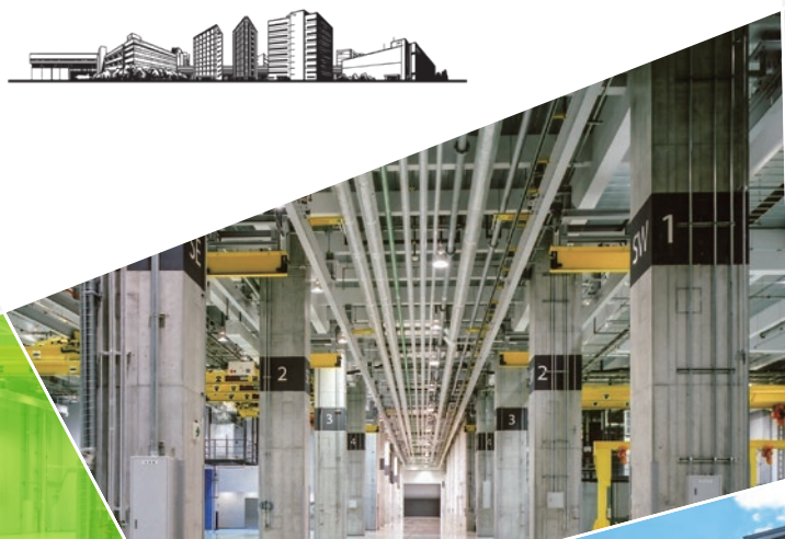
東京国際空港 エンジンメンテナンスビル南棟
