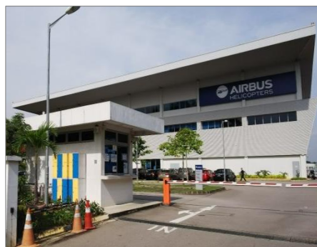
《格納庫(セレーター空港)》
