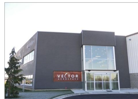
《小型機用整備施設(ラングレー空港)》
