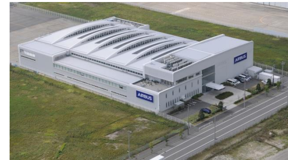
＜神戸格納庫（既存部） 外観＞
