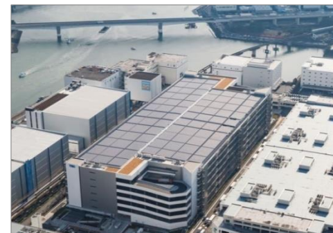
《TRC物流ビルB棟屋根ソーラー発電所》
