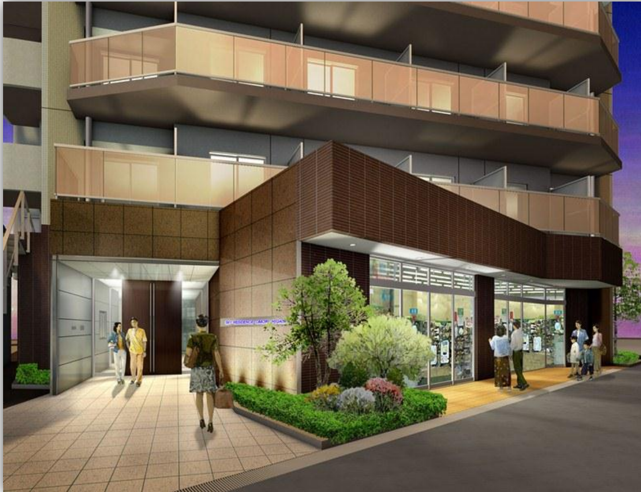
建設中のANAグループ向け共同住宅 【大田区大森東】
