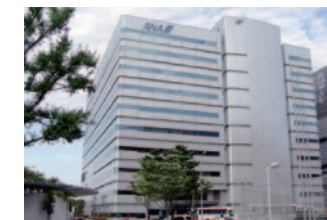
多目的ビル(ユーティリティセンタービル)
