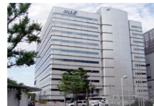
多目的ビル(ユーティリティセンタービル)
