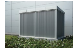
地下のクール・ヒートトレンチで取り入れた外気を安定的な地中熱で予冷、予熱
