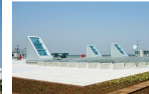
屋上より取り入れた太陽光を光ダクトで室内に導入
