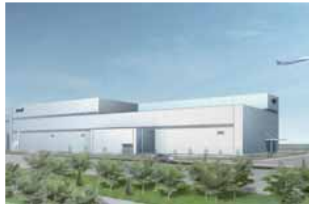
2008年竣工に向け建設中の原動機センター南棟(完成予想図) 全日本空輸(株)が航空機エンジンの整備を目的に利用予定
