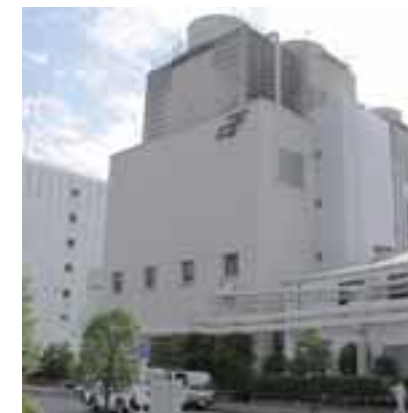
エネルギーセンター
