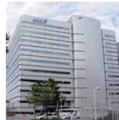
ユーティリティセンタービル
