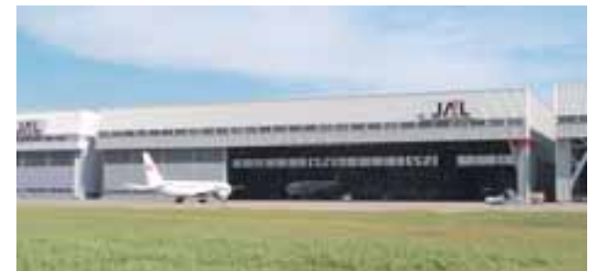
(株)日本航空インターナショナルが利用する格納庫(東京国際空港)
