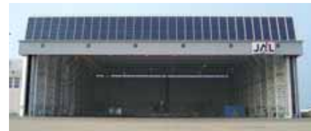
大型航空機用格納庫
