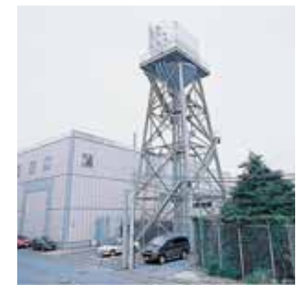
東京国際空港旧整備場地区上下水道施設
