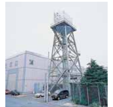
東京国際空港整備場地区上水道施設
