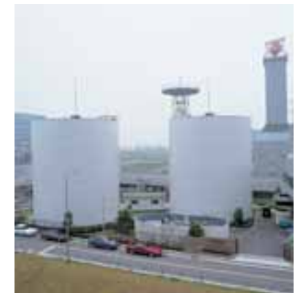
東京国際空港沖合展開地区上下水道施設
