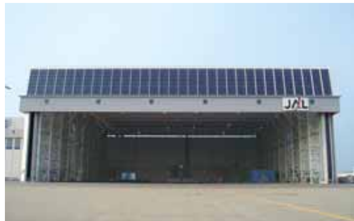
大型機用格納庫
