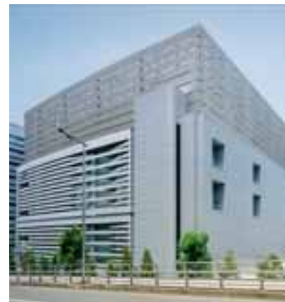
東京空港冷暖房株式会社
