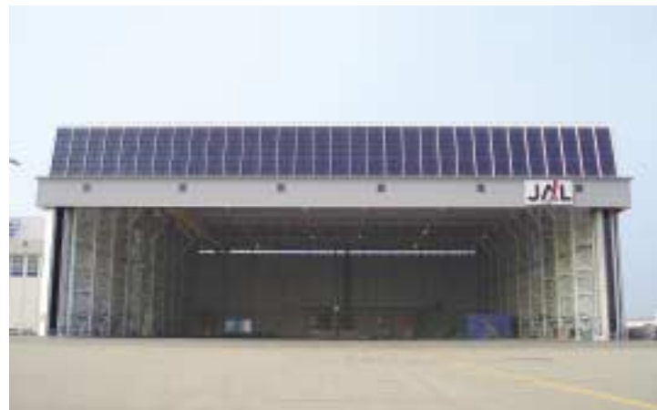
大型機用格納庫
