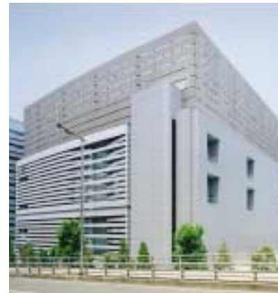
東京空港冷暖房株式会社
