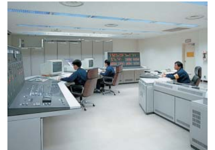
成田国際空港(株)中央受配電所監視室 (運転・監視業務)
