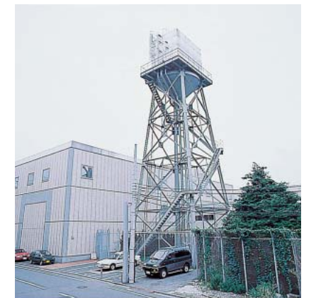
東京国際空港整備場地区 上下水道施設
