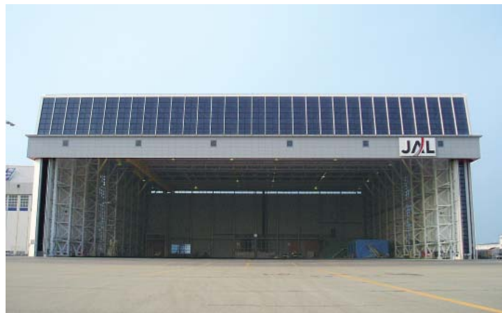
大型機用格納庫
