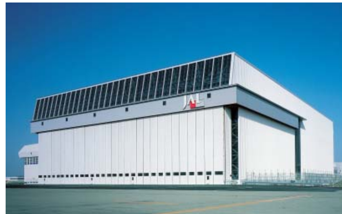
大型機用格納庫
