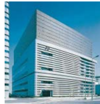
東京空港冷暖房株式会社
