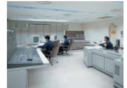
新東京国際空港公団中央受配電所監視室 (運転・監視業務)
