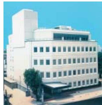
空港施設六本木ビル
