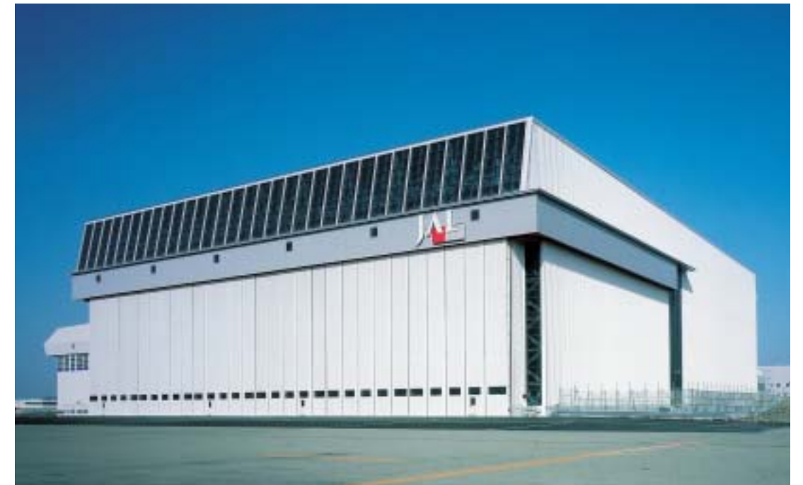
●大型機用格納庫
