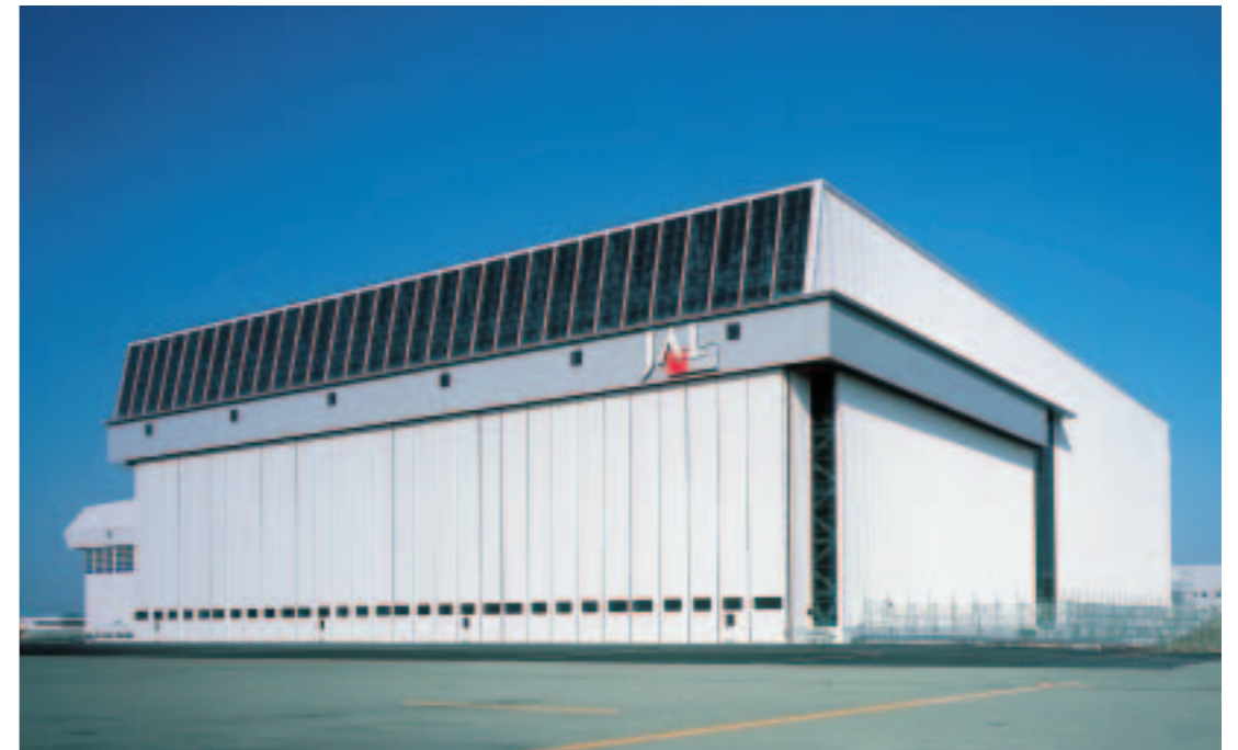
●大型機用格納庫
