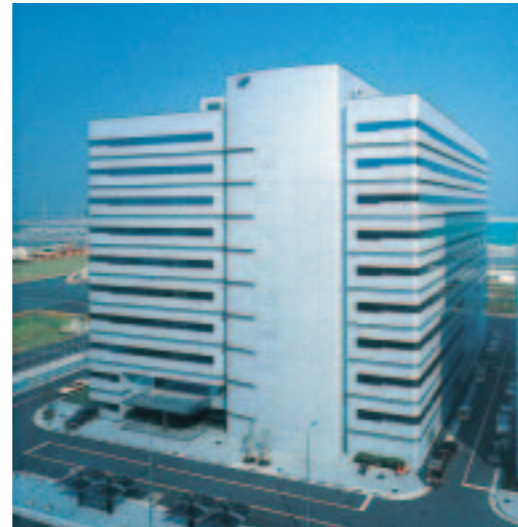
ユーティリティセンタービル
