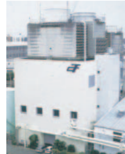
エネルギーセンター
