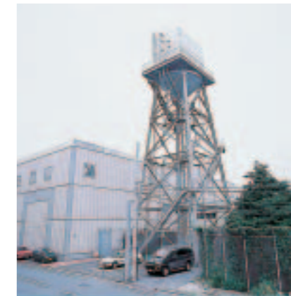
東京国際空港整備場地区上下水道施設
