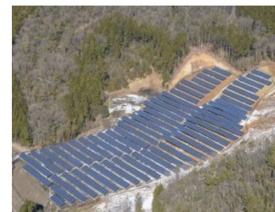
＜岐阜瑞浪ソーラー発電所＞ (年間発電量) 約1600千kWh (稼働日) 2016年1月
