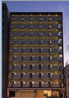
＜スカイレジデンス南蒲田＞ （2011年11月竣工）
