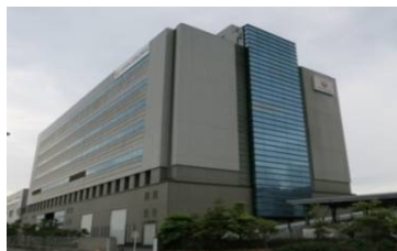
第1・第2テクニカルセンター(東京国際空港)
