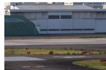
大型格納庫(東京国際空港)
