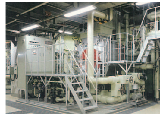
ボイラ(エネルギーセンター内)
