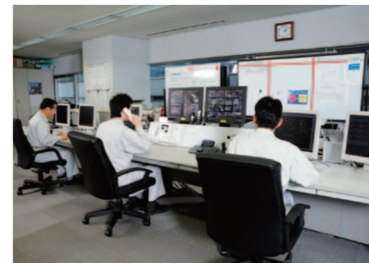
コントロールルーム
