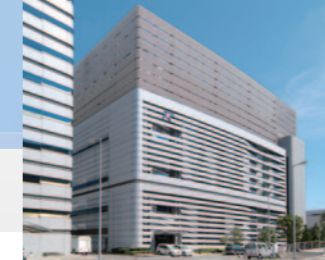
エネルギーセンター
