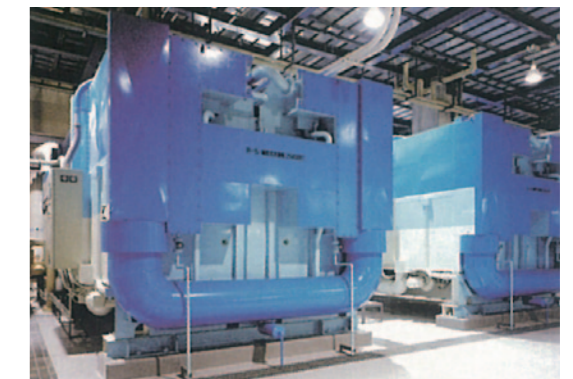
冷凍機(エネルギーセンター内)
