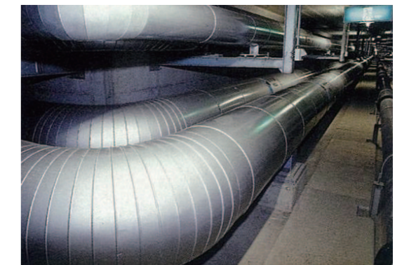
地域配管(共同溝内)
