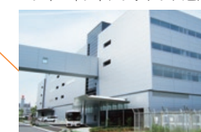
コンポーネントメンテナンスビル
