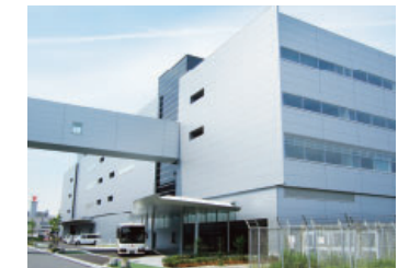
コンポーネントメンテナンスビル
