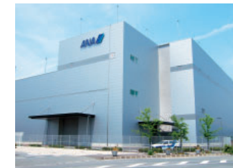
エンジンメンテナンスビル南棟
