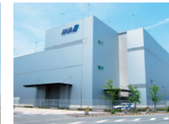
エンジンメンテナンスビル南棟
