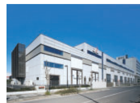
第2テクニカルセンター（増築）
