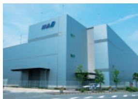
エンジンメンテナンスビル南棟
