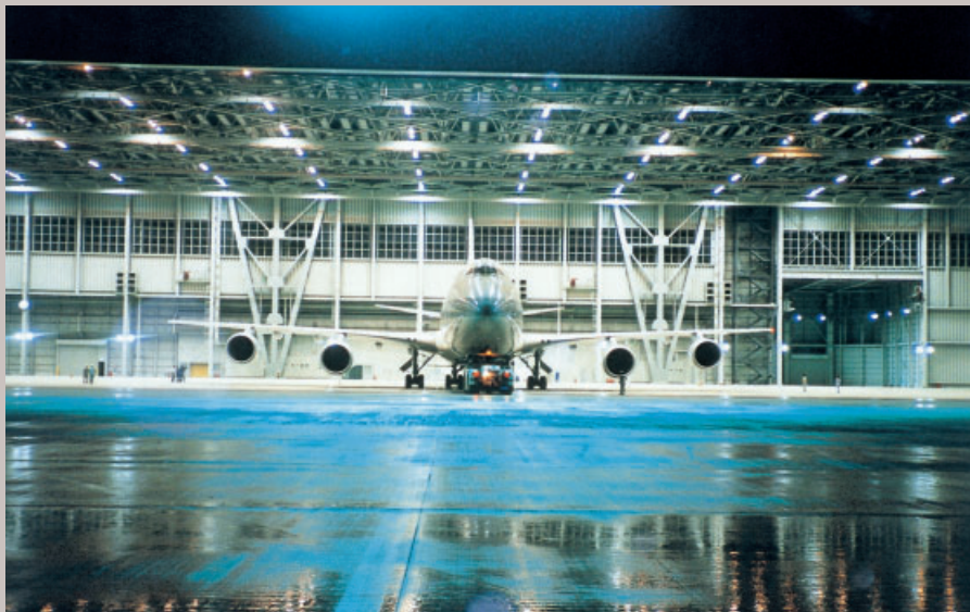
西側格納庫（東京国際空港）
