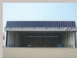
大型機用格納庫 (関西国際空港)
