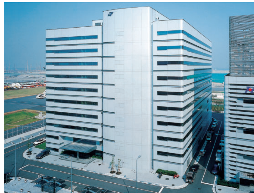
ユーティリティセンタービル
