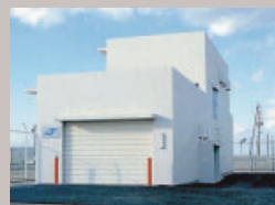
SDプラント (中部国際空港)
