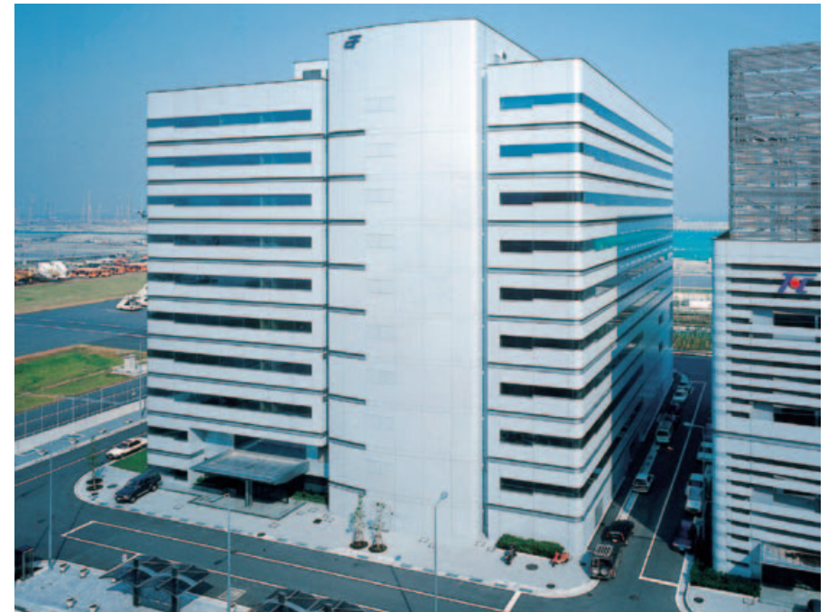
ユーティリティセンタービル
