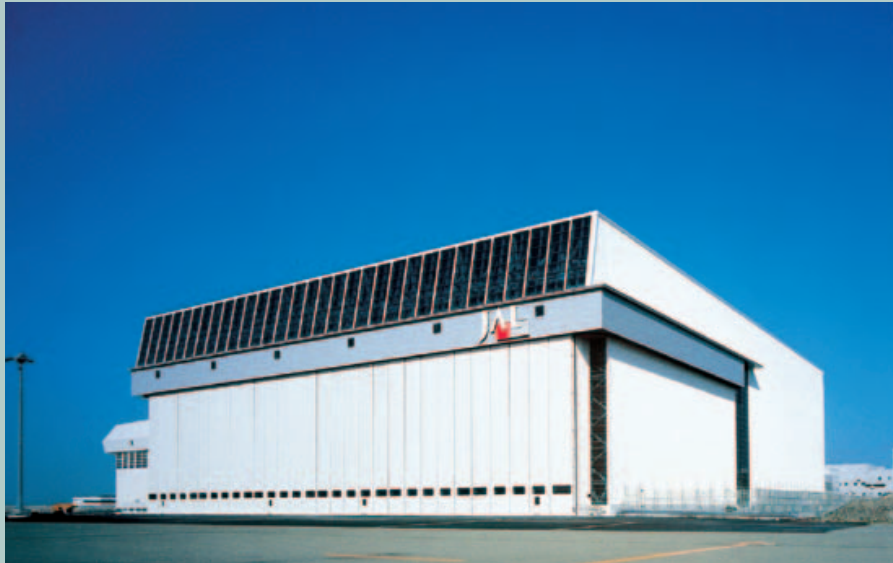
大型機用格納庫（関西国際空港）
