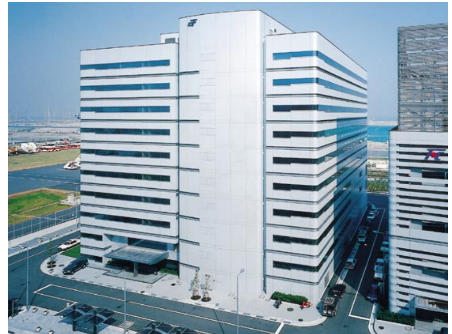
ユーティリティセンタービル
