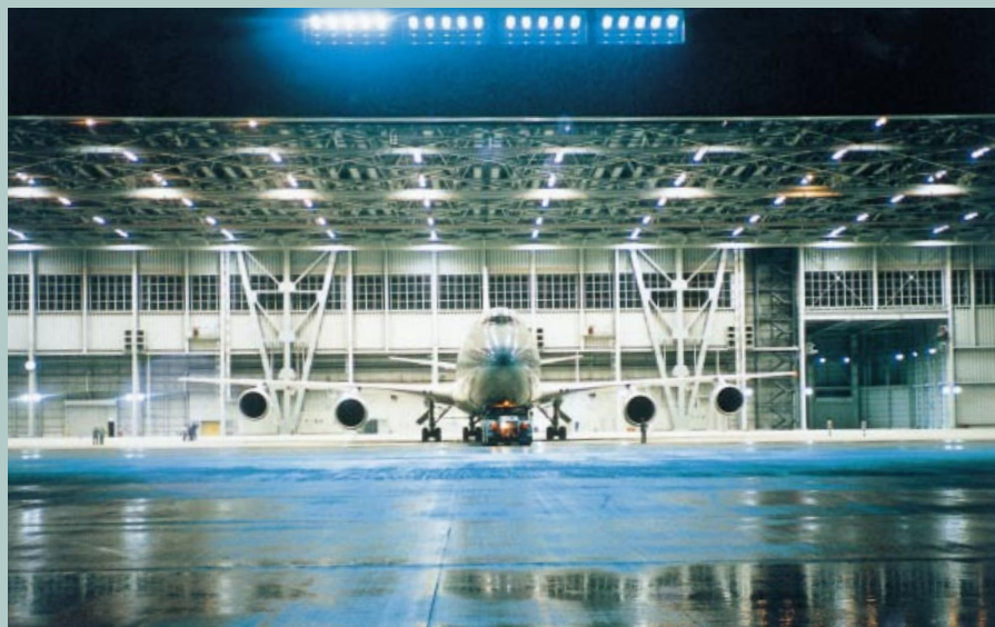
西側格納庫（羽田空港）
