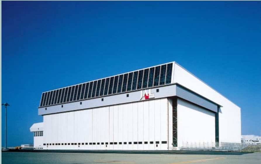
大型機用格納庫（関西国際空港）
