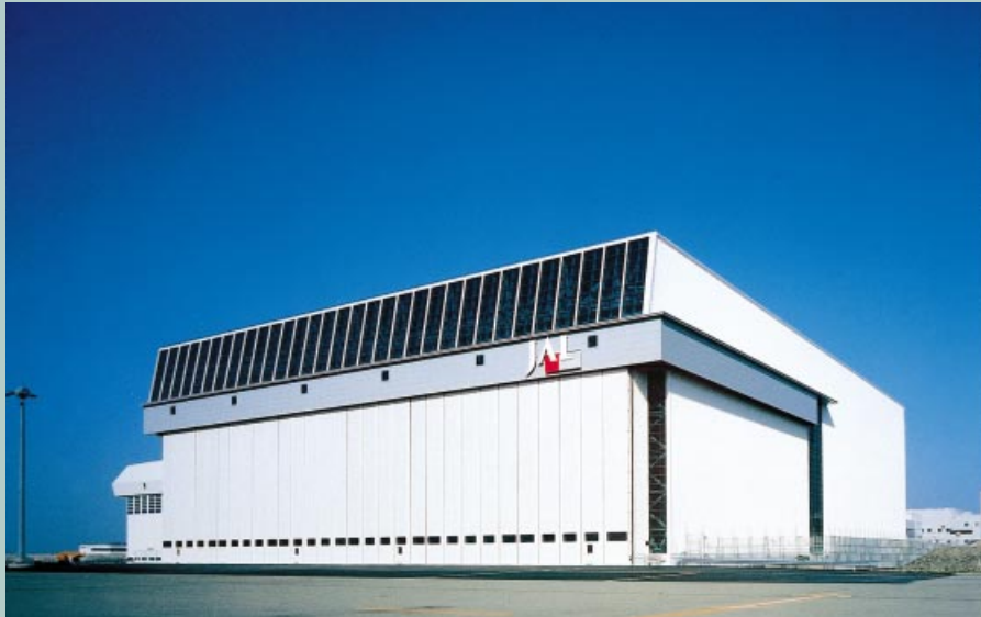
大型機用格納庫（関西国際空港）
