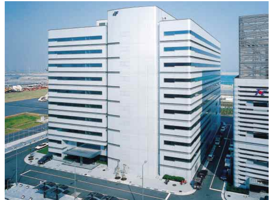
ユーティリティセンタービル
