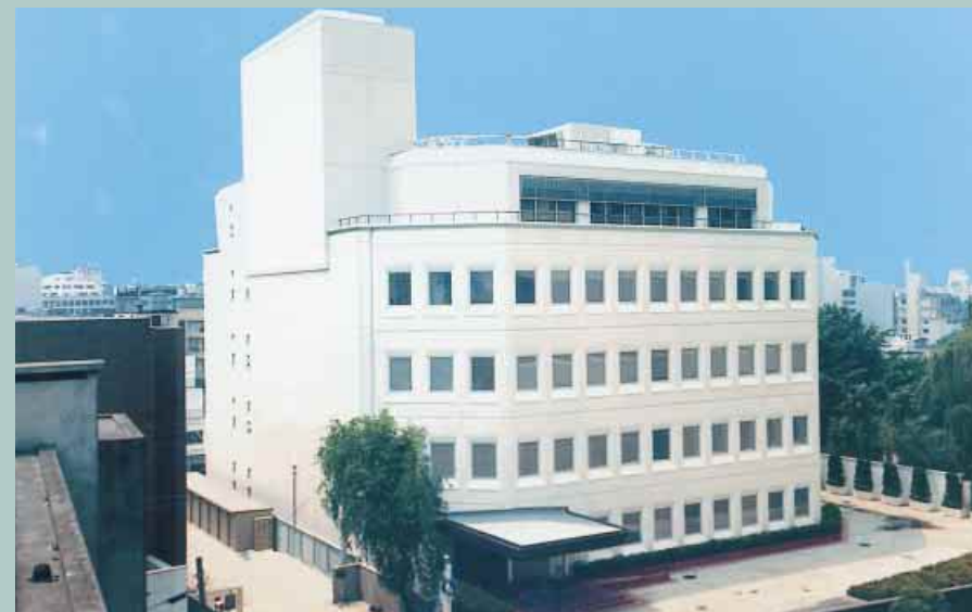
空港施設六本木ビル
