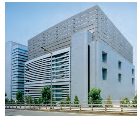
効率的かつ環境に優しい熱源を供給する エネルギーセンター
