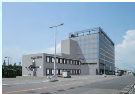
アークビル機内食工場(増改築)
