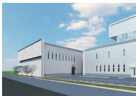
神戸空港格納庫(増築)
