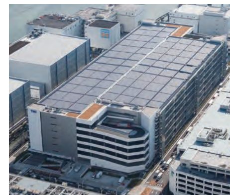
約620世帯が1年間で消費する電力を発電できる TRC物流ビルB棟屋根ソーラー発電所
