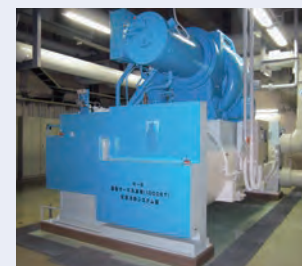
高効率電動ターボ冷凍機 High-efficiency Electric Turbo Chiller
