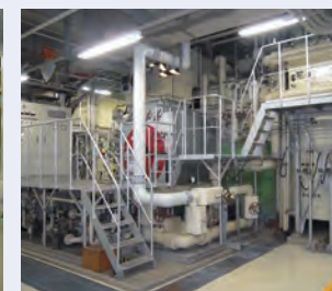
水管式ボイラー Water-tube Boiler
