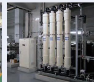
冷却水フローリサイクル装置 Coolant Water and Blow-off Water Recycling Device
