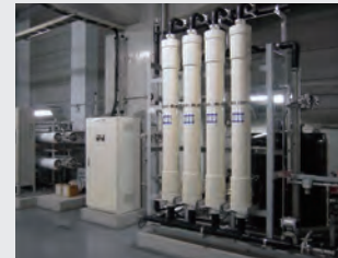
冷却水ブロー水リサイクル装置 Coolant water and blow-off water recycling device
