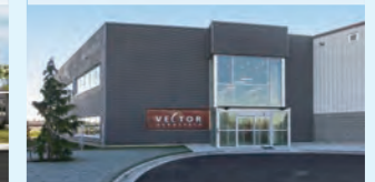
ヘリコプター整備施設 Helicopter Maintenance Facility
