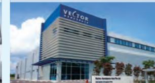
エンジン整備工場 Engine Maintenance Shop
