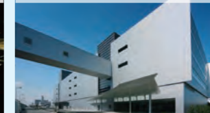
コンポーネントメンテナンスビル Component Maintenance Building
