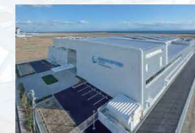
開放感のあるエントランス Entrance that gives an open feeling
