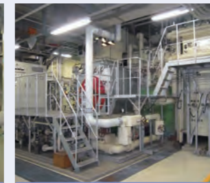
水管式ボイラー Water-tube Boiler
