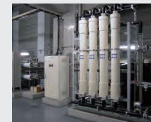
冷却水ブロー水リサイクル装置 Coolant water and blow-off water recycling device
